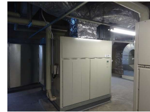
国際線空調機の更新
