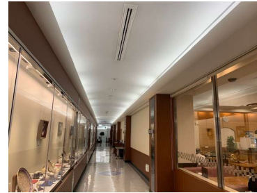
館内照明(エアポートギャラリー通路)のLED化
